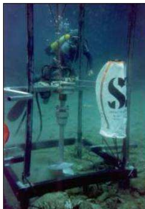
Etape intermédiaire de pose d'une ancre hélicoïdale avec dispositif hydraulique (Neptune Environnement 1999)
